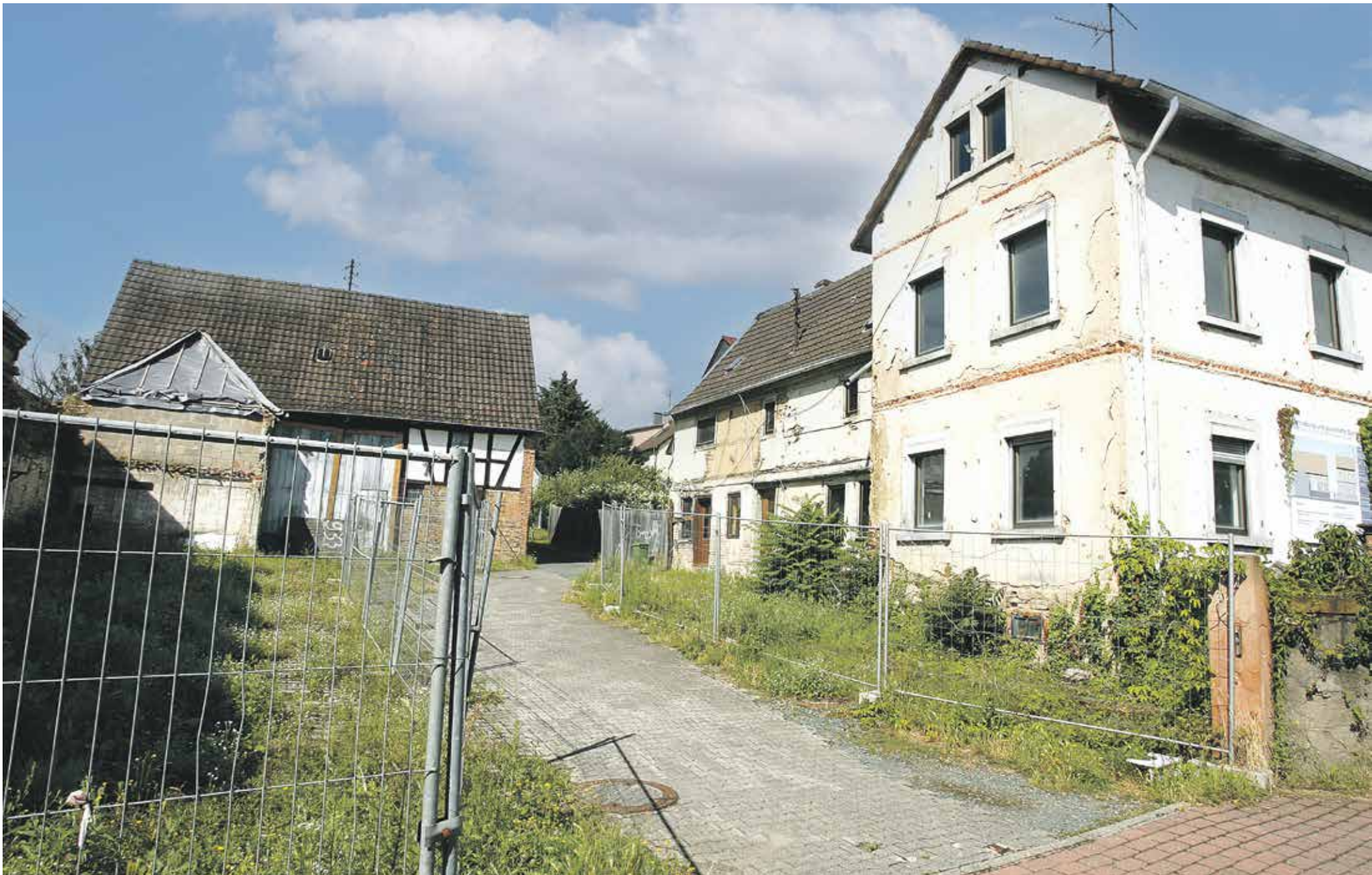
Die Hofreite muss endlich saniert werden! Das Projekt verzögert sich vor allem durch mangelndes Engagement.
